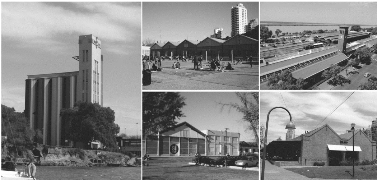
Figura 8. Reversión del patrimonio ferro-portuario en la costa central de Rosario: Silos Davis, galpones portuarios, estación Rosario Central y galpón N°10. Fuente: Fotografías de la autora.
